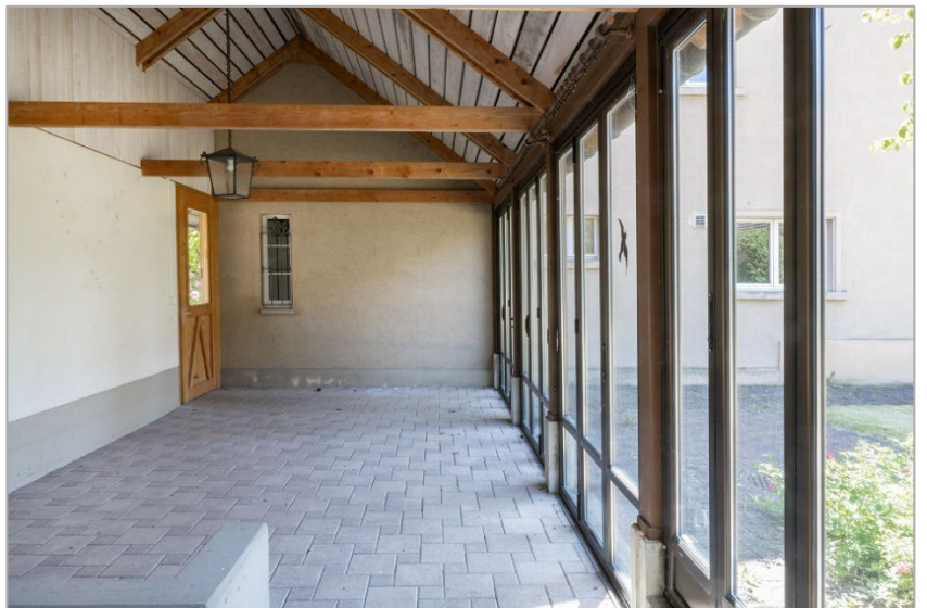
Überdachte und verglaste Terrasse
